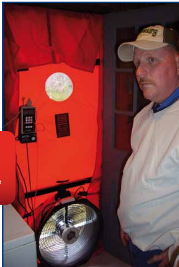
Blower Door System
